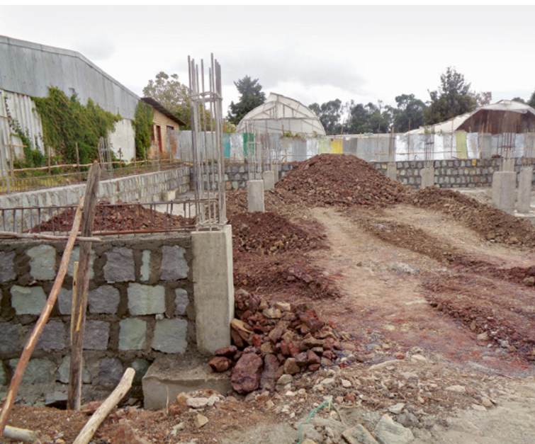
Baustelle neue Kinderhäuser
