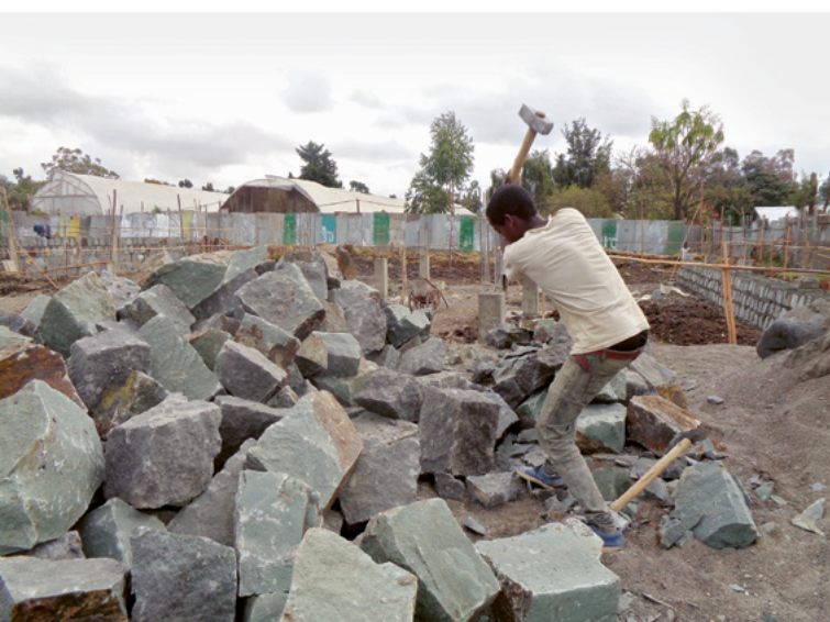
Die Steine müssen für die Mauer zurecht gehauen werden
