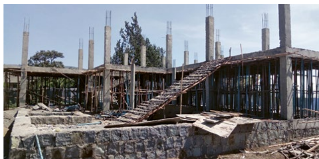
Baustelle neue Kinderhäuser Selam 1
